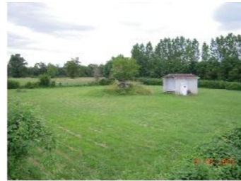
Captage Puits des Coutures - Ribérac
