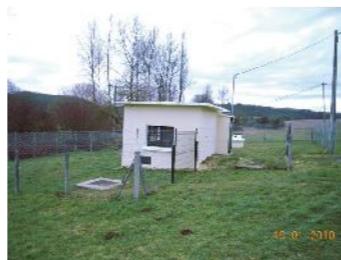
Captage Puits Les Farges - Paussac
