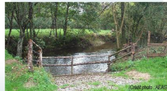
(Crédit photo : AEAG) Descente aménagée
