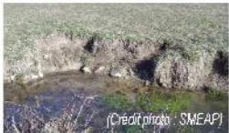
(Crédit photo : SMEAP) Berge dégradée et dénudée par le bétail sur l'Eucho
