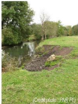
(Crédit photo : FNB PL) Encoche d'érosion sur les rives de la Lizonne
